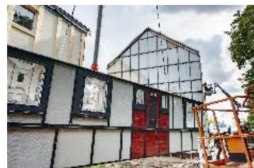
Quelle: Tamara Pribaten/dena
