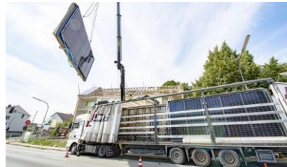
Quelle: Tamara Pribaten/dena
