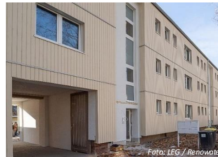
Foto: LEG / Renovate
