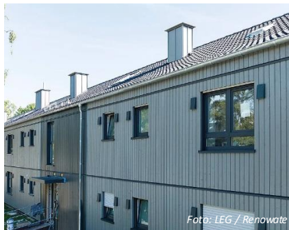
Foto: LEG / Renovate
