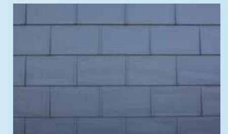
Vorgehängte hinterlüftete Fassaden mit kleinformatigen Plattenwerkstoffen.
